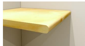
Rys. 346 – profil dwustronnie zaokrąglony
