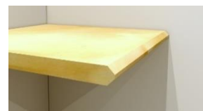
Rys. 348 – profil dwustronnie ścięty
